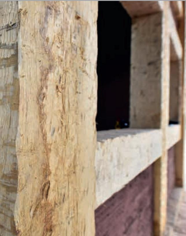
*Detailgetreue Rekonstruktion: Durch eigens dafür entwickelten Maschinen sehen die Balken des Neubaus aus als seien sie gehobelt.*
