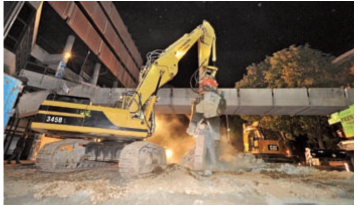
Bis 4 Uhr morgens bissen sich die Bagger Stück für Stück durch die Betonschichten der alten UB-Brücke. Foto: Bamberger
