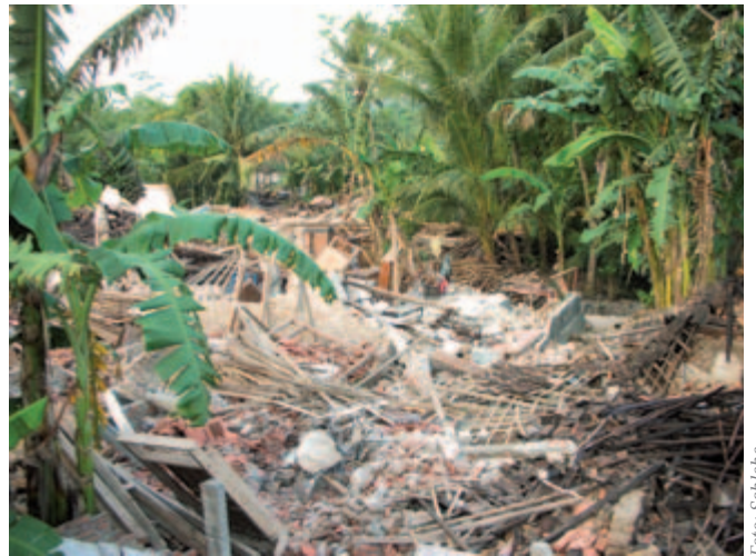
Viele Häuser wurden durch das Erdbeben komplett zerstört
