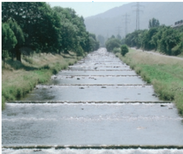
Unterhalb des Innenstadtbereichs ist die geradlinig kanalisierte Dreisam durch beidseitige Hochwasserdämme, Sohlschwellen und Sohlbefestigungen außerordentlich strukturarm und nur noch ein technisches Bauwerk ohne natürliche Strukturen
