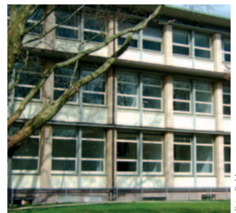
Das alte Pathologiegebäude in der Albertstraße 19 ist jetzt Sitz des FRIAS
