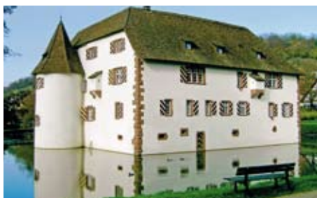
Das Wasserschloss in Inzlingen: Ein Wassergraben sollte die Bewohner vor Eindringlingen schützen.
