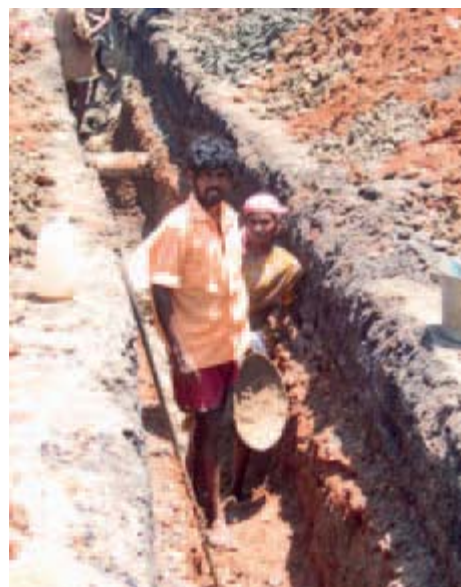
Verlegung neuer Wasserrohre
