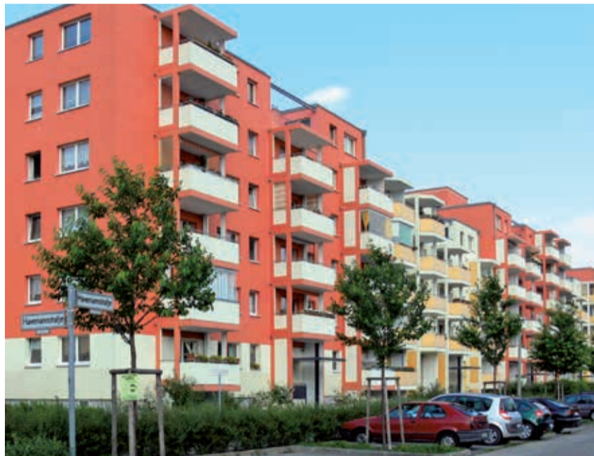
Balkone, Farbe und der Rückbau von Hochhäusern holten viele neue Bewohner nach Berlin-Marzahn. Trotzdem besteht die Gefahr der Ghettoisierung.
