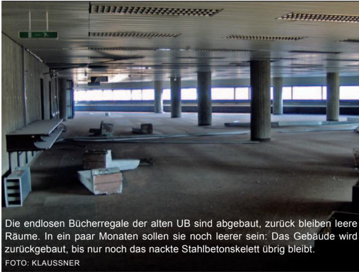
Die endlosen Bücherregale der alten UB sind abgebaut, zurück bleiben leere Räume. In ein paar Monaten sollen sie noch leerer sein: Das Gebäude wird zurückgebaut, bis nur noch das nackte Stahlbetonskelett übrig bleibt.
