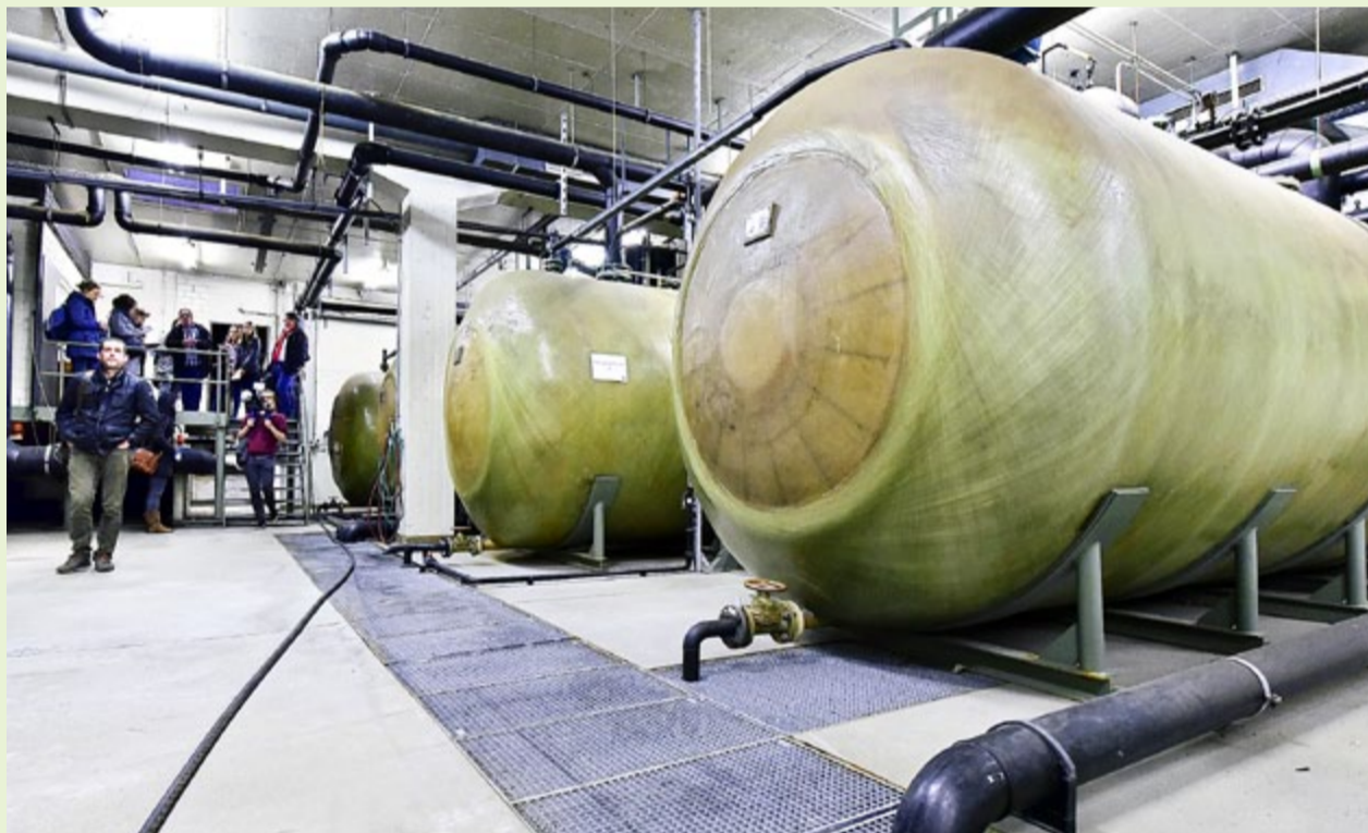
In riesigen Kunststofftanks wird das Laborabwasser unter Zugabe von Säure beziehungsweise Lauge neutralisiert.
